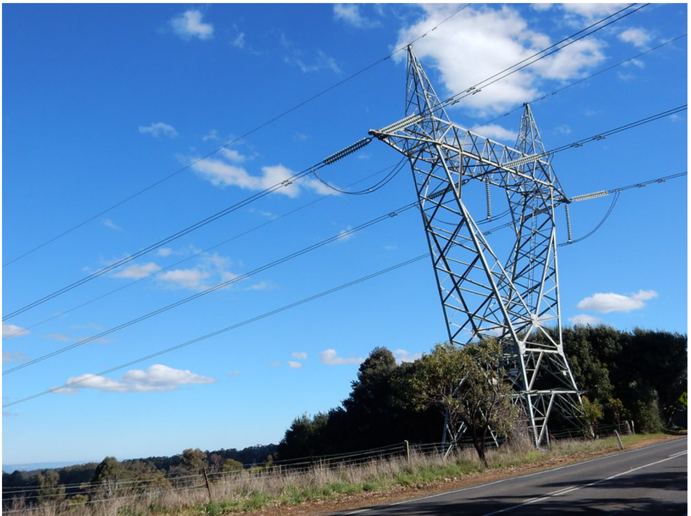
Afbeelding 1. Een hoogspanningsmast. Verrassend maar waar: de energie stroomt niet
