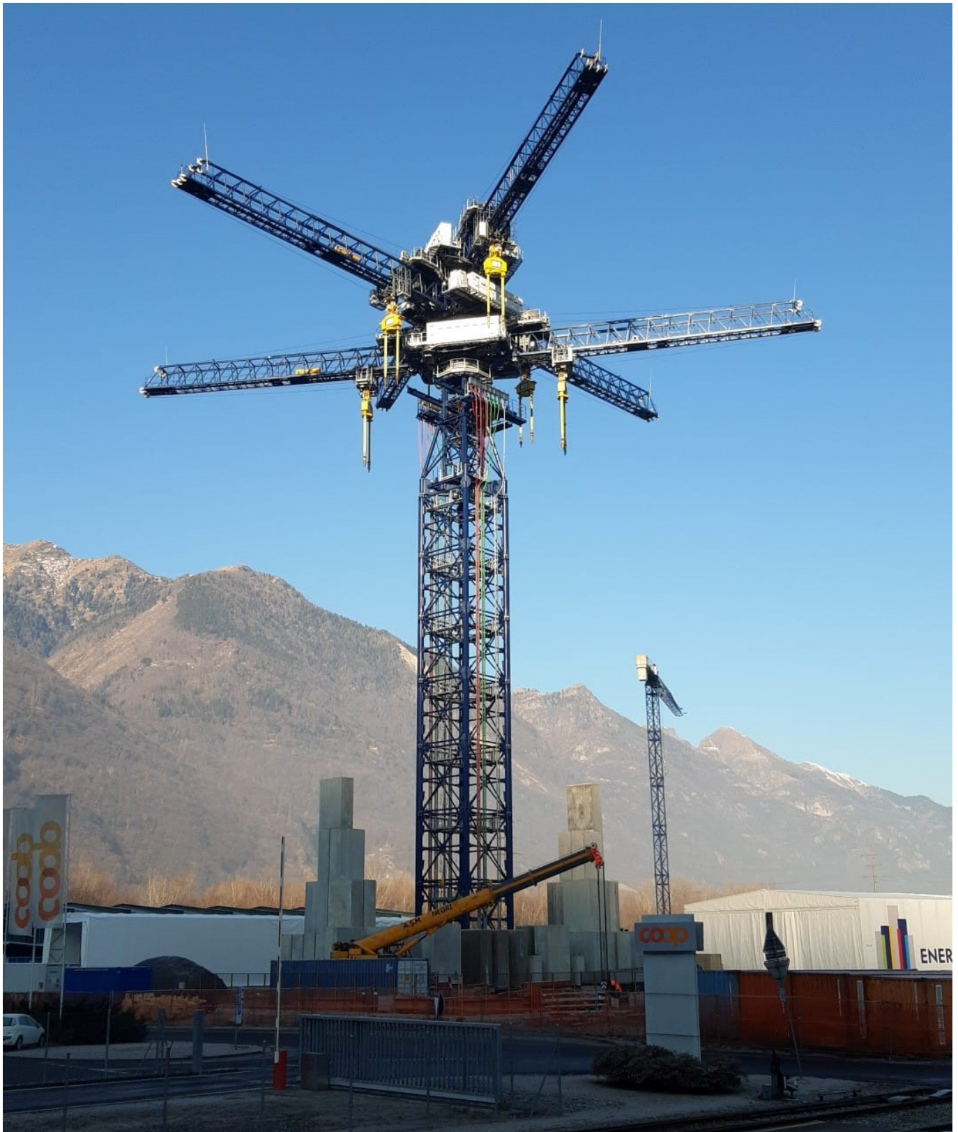
Afbeelding 4: De “commerciële demonstratie-unit” van Energy Vault. Dit prototype in Castione, Zwitserland, kan 35 megawattuur aan stroom opslaan en leveren, door zware blokken op te tillen en te stapelen. Het
